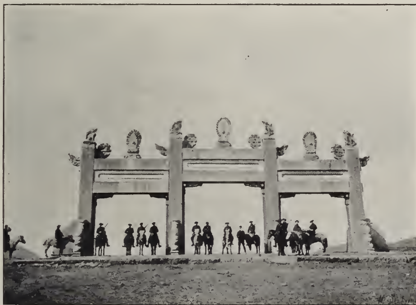
Portique de Chen-che-chan.
