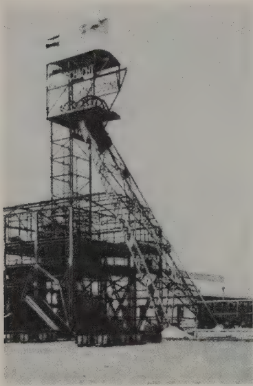
Kohlenbergwerk der Schantung-Bergbau-Gesellschaft bei Weixian: Förderanlage am Annie-Schacht, um 1908.
