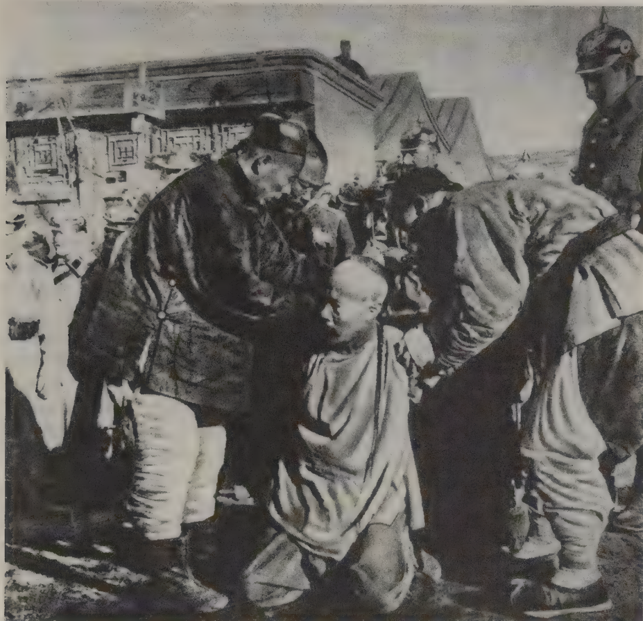
Unter deutscher Aufsicht wird die Hinrichtung eines hochrangigen Qing-Beamten vorbereitet.
