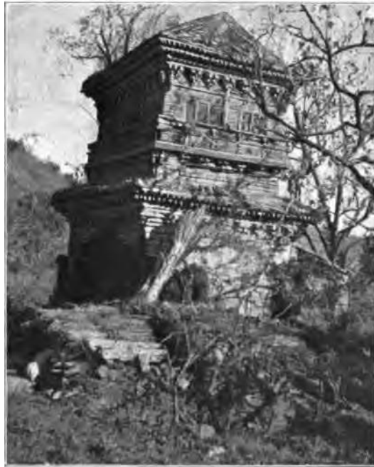
Bauwerk in der Nähe der Kin-Gräber.
