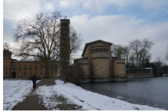
Die 1848 fertiggestellte Friedenskirche
